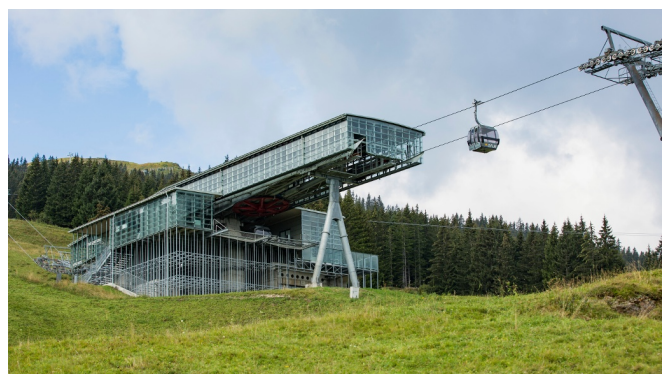
Golmerbahn Mittelstation Matschwitz
